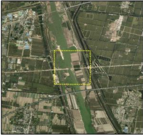
(a) 在建桥梁及栈桥遥感影像
