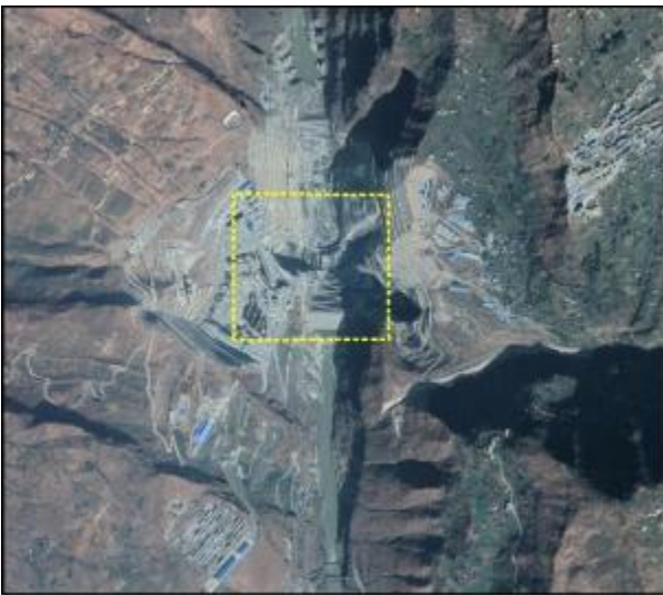
(a) 在建拦河闸坝（橡胶坝）遥感影像（导流暗渠）
