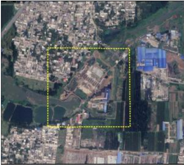
(c) 在建拦河闸坝（橡胶坝）遥感影像（导流明渠）
