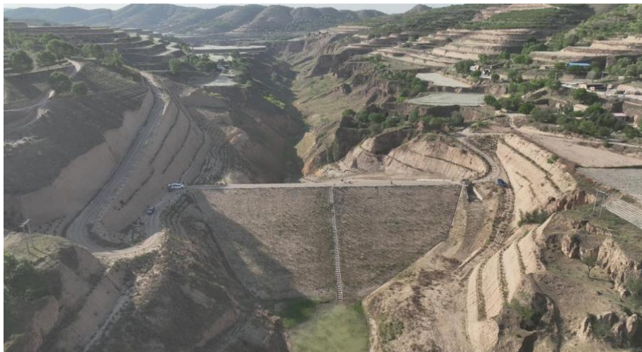
图 3.2-4 彭阳县唐川大型淤地坝项目
