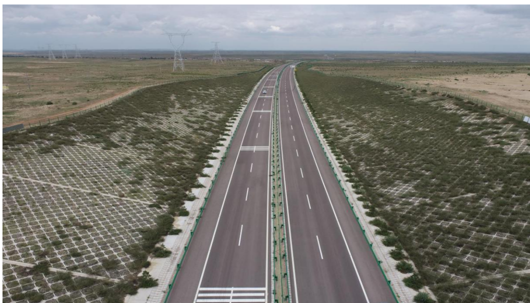
图 2.7-2 银川至百色公路宁东至甜水堡段（框格护坡）
