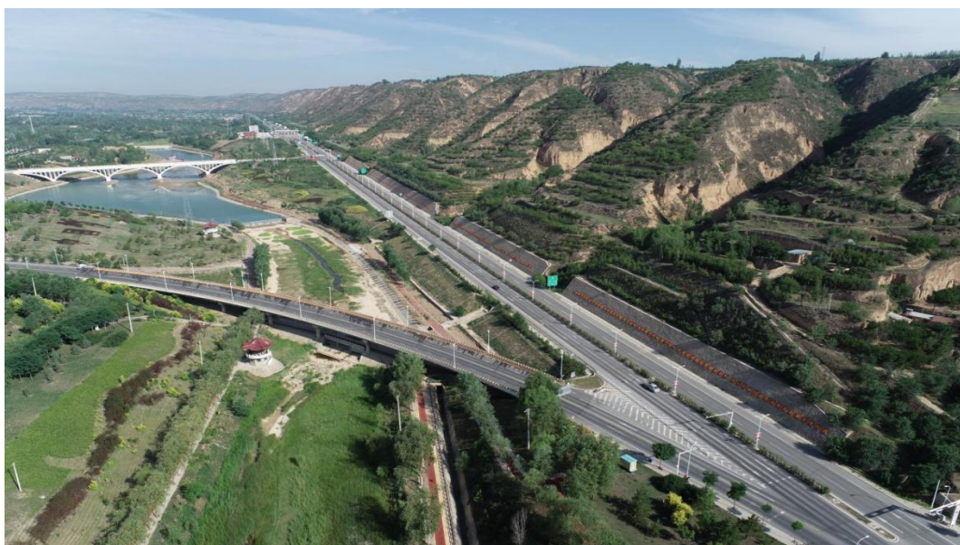
图 2.7-3 彭阳至青石嘴公路项目（边坡综合防护）
