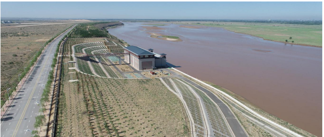
图 2.4-1 银川都市圈中线供水工程（泵站工程区综合治理）
