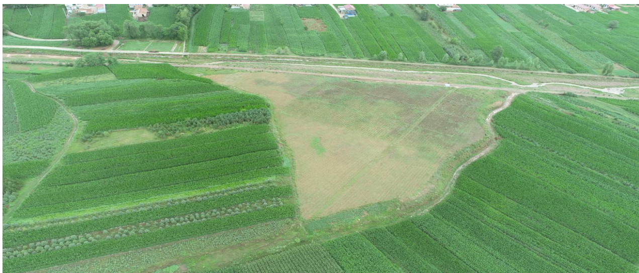
图 2.5-1 G85 银昆高速公路（弃土场治理）
