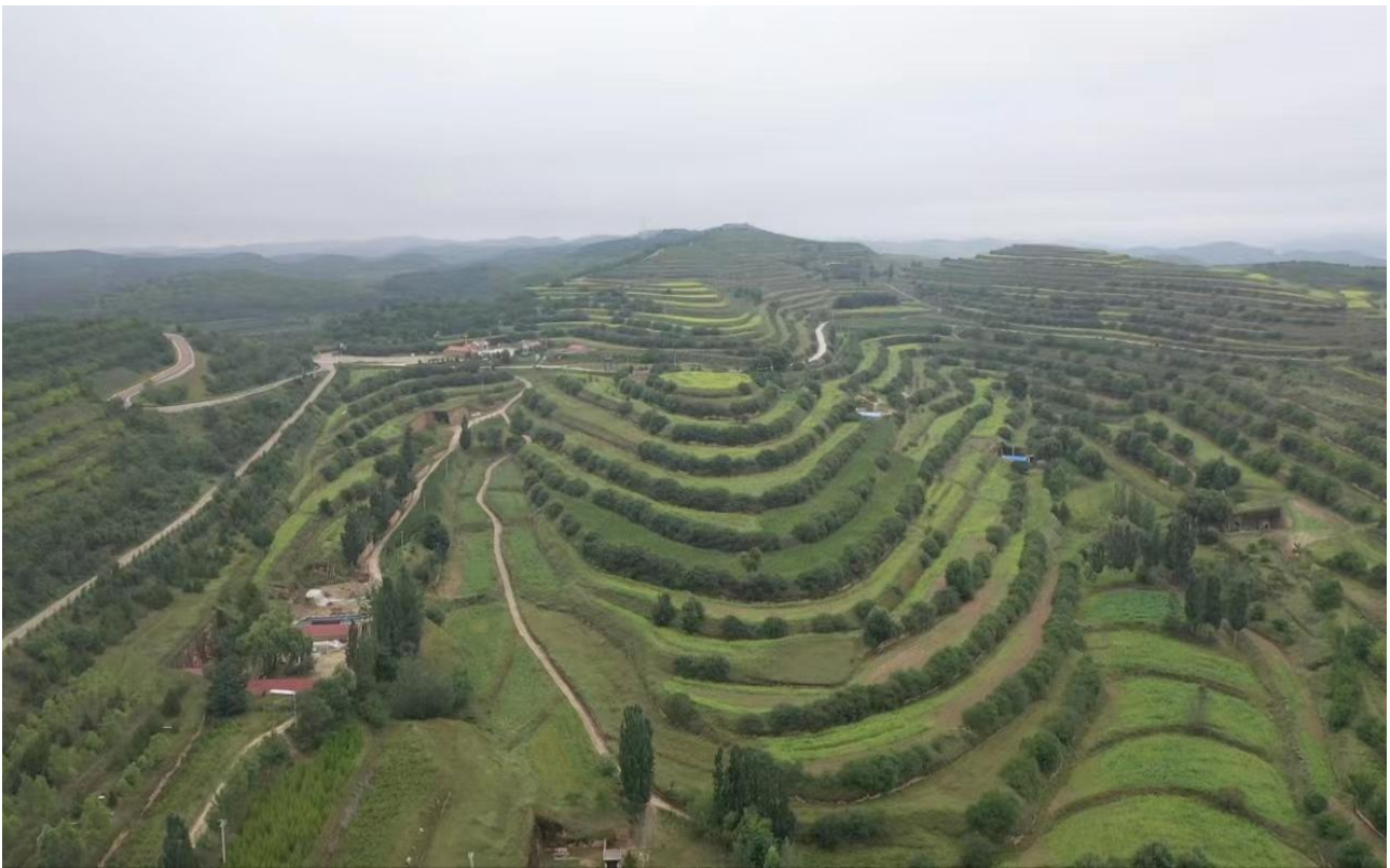
图 3.2-1 彭阳县王洼镇杨寨片区坡耕地水土流失综合治理项目
