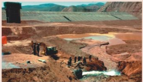
图为海原县新区供水工程通水
