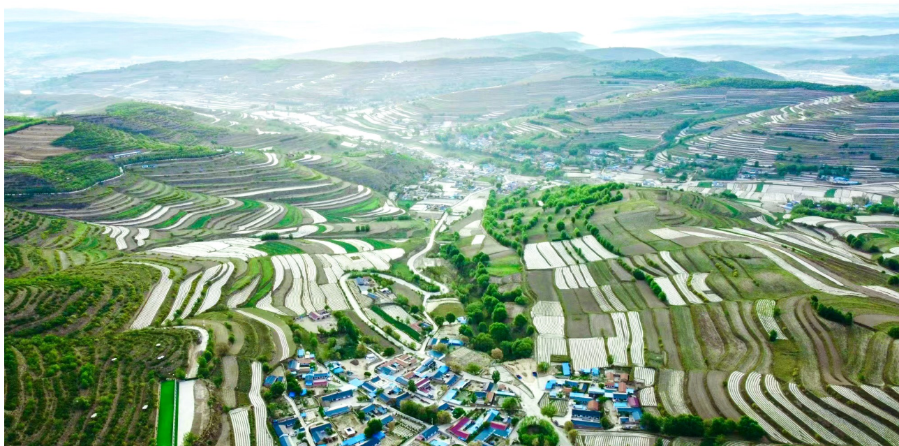
图3-3 西吉县龙泉湾小流域综合治理
