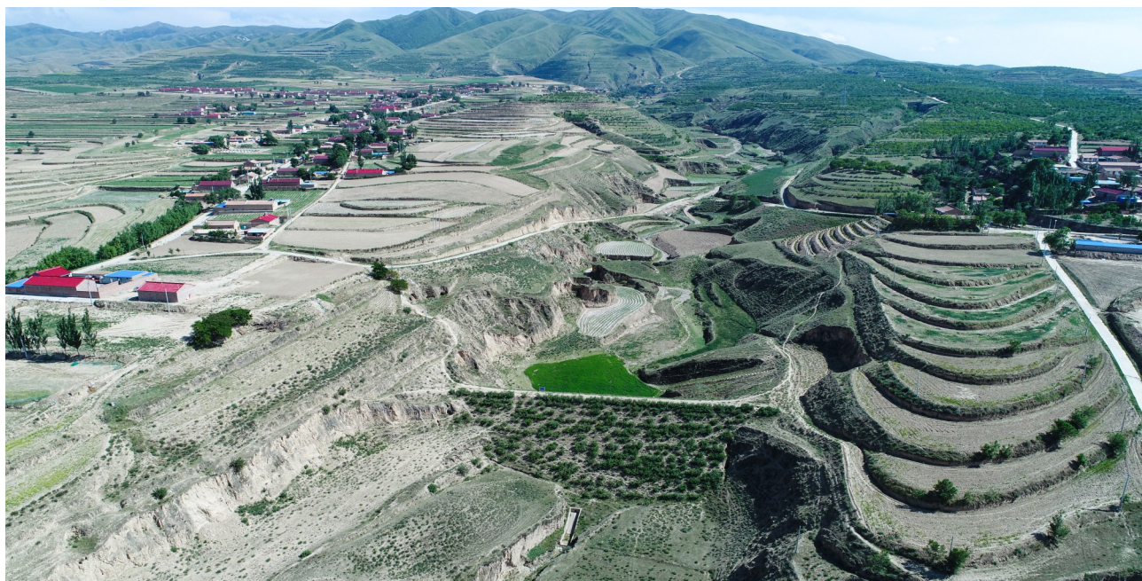
图3-4 海原县菜园陡沟中型淤地坝
