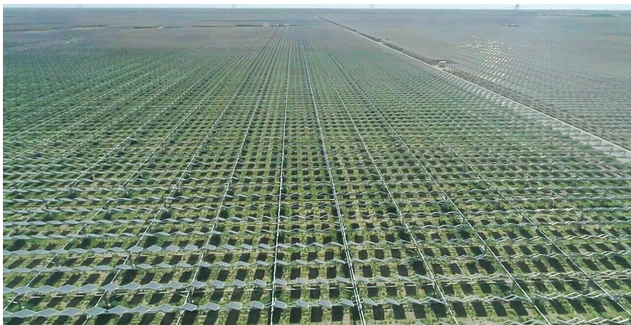
图2-2 宁夏宝丰光伏发电有限公司红墩子光伏产业综合示范园一期 350MWp 光伏发电项目(植物措施)
