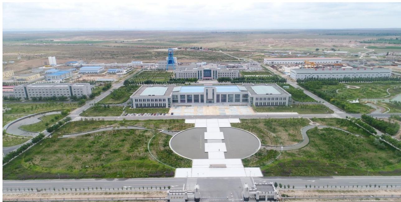
图2-3 金家渠煤矿项目水土保持措施实施效果图
