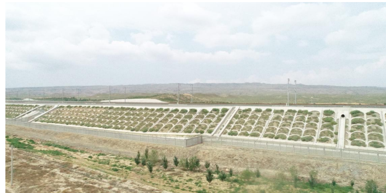
图2-1 吴忠至中卫铁路项目路基边坡绿化
