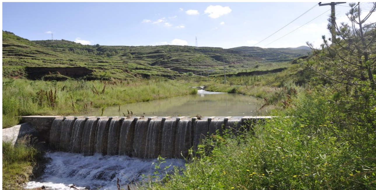
图 3-2 隆德县渝河小流域小型水保工程-石谷坊
